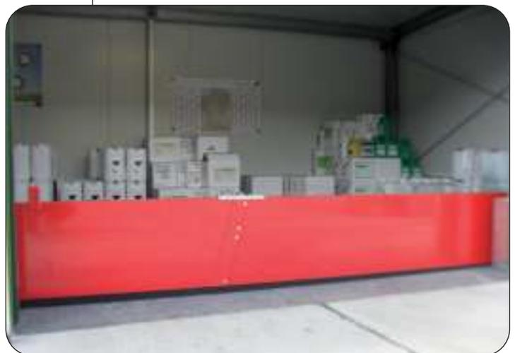
Löschwasserrückhaltung mit dreh-klappbarer Barriere
