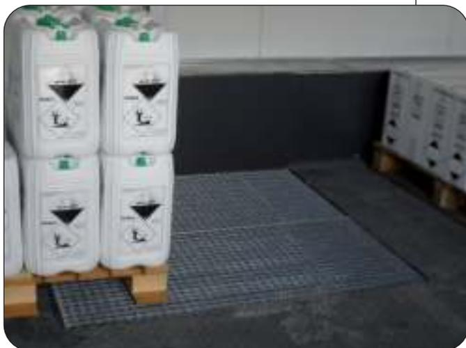
Geneigte Lagerfläche mit Pumpensumpf
