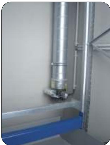
Ex-Abluftanlage inkl. brandgeschützter Lüftungselemente
