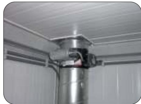
Abluftkanal mit K-90 Absperrvorrichtung
