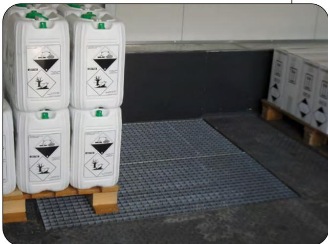
Geeignete Lagerfläche mit Pumpensumpf
