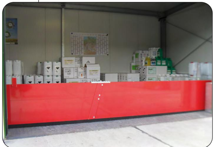
Löschwasserrückhaltung mit dreh-klappbarer Barriere
