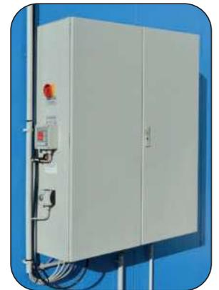
Schaltschrank mit zentraler Steuerung und Bedienelementen
