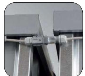
Optionale Steckverbindung bei SLH Kombination
